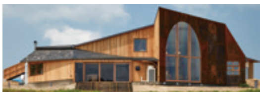
【木造非住宅施設の事例】サステナブル ファーム&パーク「KURKKU FIELDS」 千葉県木更津市にある30haの農場で体験する「農業」「食」「アート」、これからの豊かさを提案する場。住友林業がレストラン棟「ダイニング・ペカリー」などの施設を木造で施工。今秋オープン予定だったが、台風15号による農作物の被害や停電の影響により延期(本誌発行の頃には復旧することを願います)
